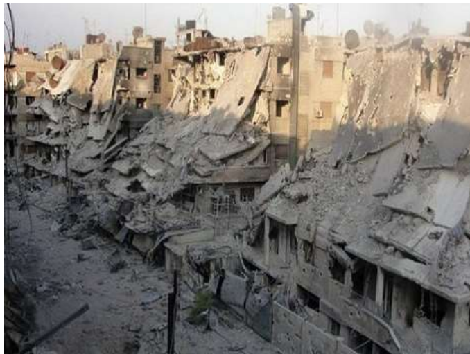
“صورة لدمار ناتج عن قصف صاروخي لأحد أحياء مدينة حلب”- إنترنت
